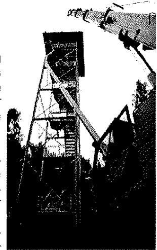
In knapp 25 Metern Höhe baumelte am Freitag das Kuppeldach des neuen Aussichtsturms auf dem Sauensieker Litberg. Kommenden Dienstag soll das 163 000 Euro teure Projekt fertig sein. Foto: Hamann
